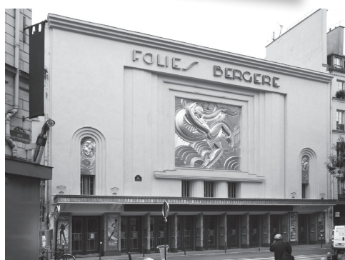
A színház homlokzata 2013-ban...
